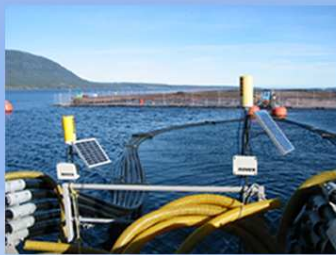
Fig 2. Detalle de los paneles solares que alimentan las unidades de medición Sea Control en las jaulas de producción
