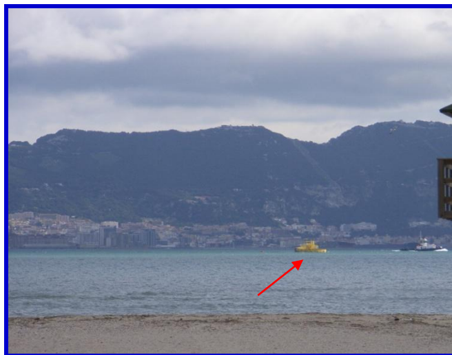
Fig. 7. Instalación marítima Monoboya de la Refinería de Cepsa Gibraltar-San Roque. Fuente imagen: Demarcación de Costas
