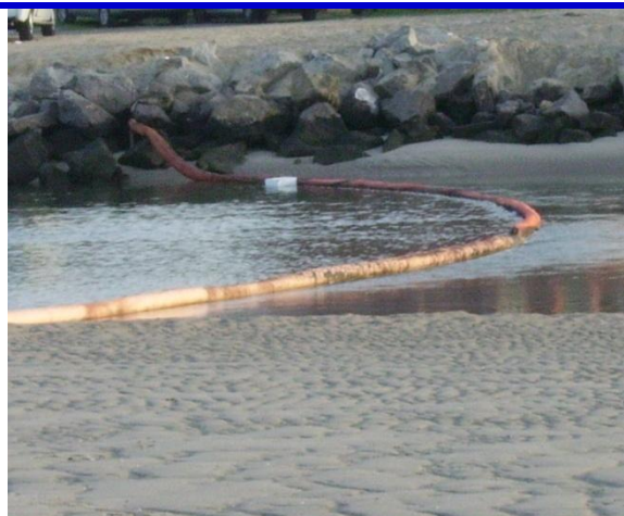
Fig. 20. Detalle barrera de contención frente vertido b/Tawe.
